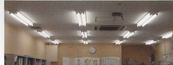
逆富士型を連結していないオフィスにおいては天井面に光のムラが出来るため、かえって暗い印象を与がちです。
