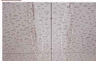
従来器具を取り外すと天井には器具跡が残っています。器具跡はリニューアル時の大きな問題点です。
