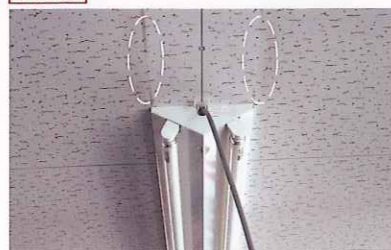
従来器具を取り外すと天井には器具跡が残っています。器具跡はリニューアル時の大きな問題点です。
